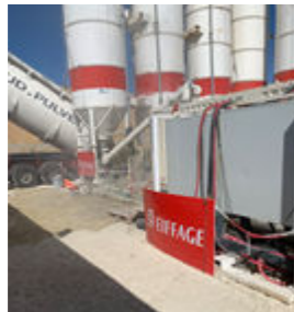
■ Centrale à béton, travaux de forages profonds sur chantier
