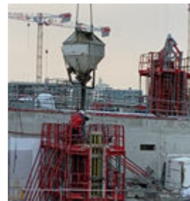
■ Activité remplissage vibration béton du coffreur équipé, chantier du Grand Paris
