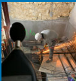
■ Utilisation disqueuse du coffreur, chantier de restauration de l'hôtel de Feuquières
