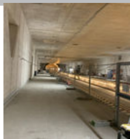
■ Tunnel du Grand Paris, future ligne 15 du métro, les Ardoines
