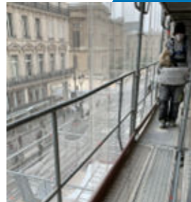
■ Activité tailleur de pierre, chantier de restauration de façade d'immeuble haussmannien
