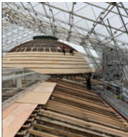
■ Rénovation de la toiture, chantier Versailles
